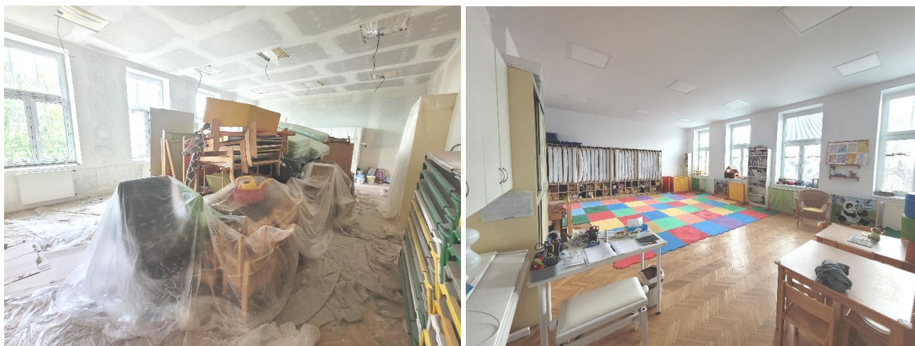
Rekonstrukce lehárny v 2. NP
